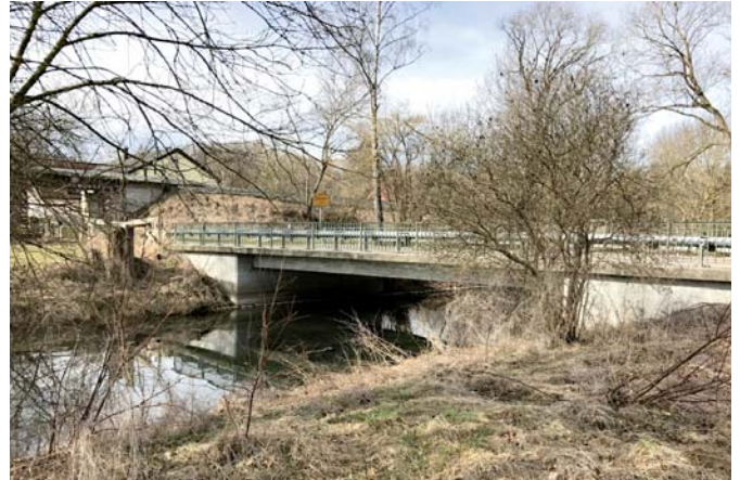
Brenzkanalbrücke am Ortseingang von Bergenweiler. Foto: G. Neumann
